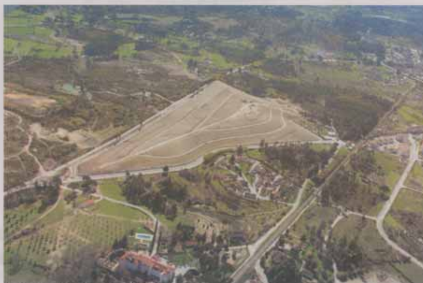
Aspecto geral da mina após reabilitação
