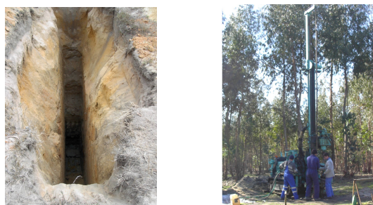
Figura 3 - Vala e sondagens mecânicas
